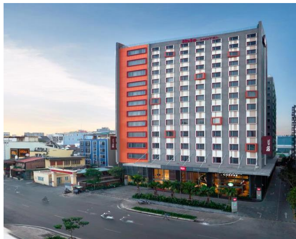
HÀ ĐÔ SÂN BAY Hệ thống an ninh Jablotron Quy mô: 13 tầng cao, diện tích sàn 17.000 m 2
