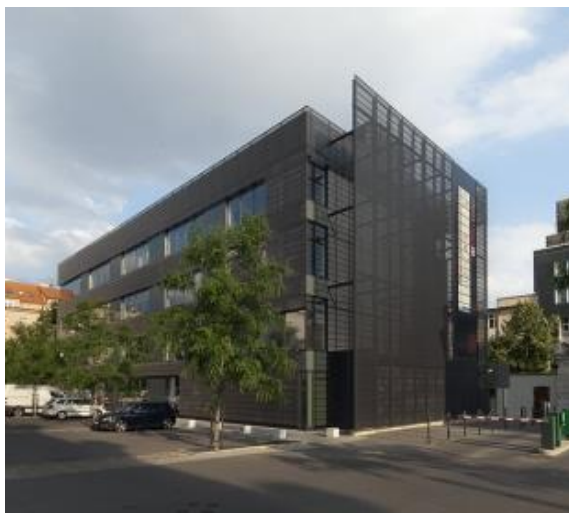
A7 OFFICE CENTER Hệ thống 2N IP Intercoms
