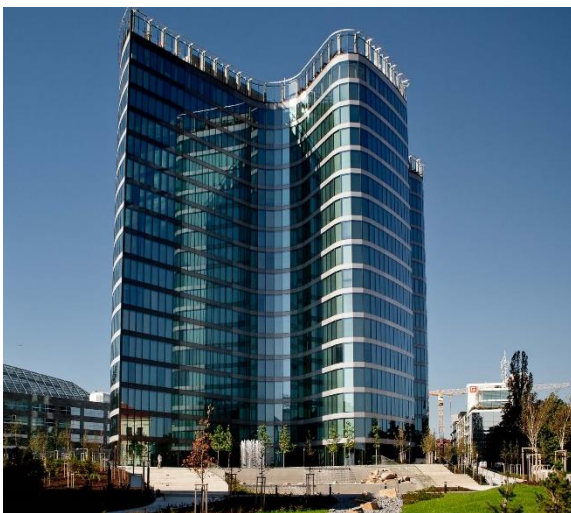
UNICREDIT BANK Hệ thống 2N IP Intercoms
