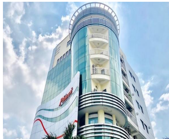
TÒA NHÀ PHỤ NỮ QUẬN 2 Hệ thống an ninh Jablotron Quy mô: 2.000m 2
